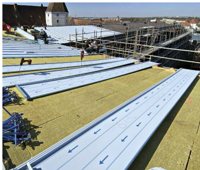
Montage der Metalldachdeckung auf der trittfesten Wärmedämmung aus Mineralfaser
