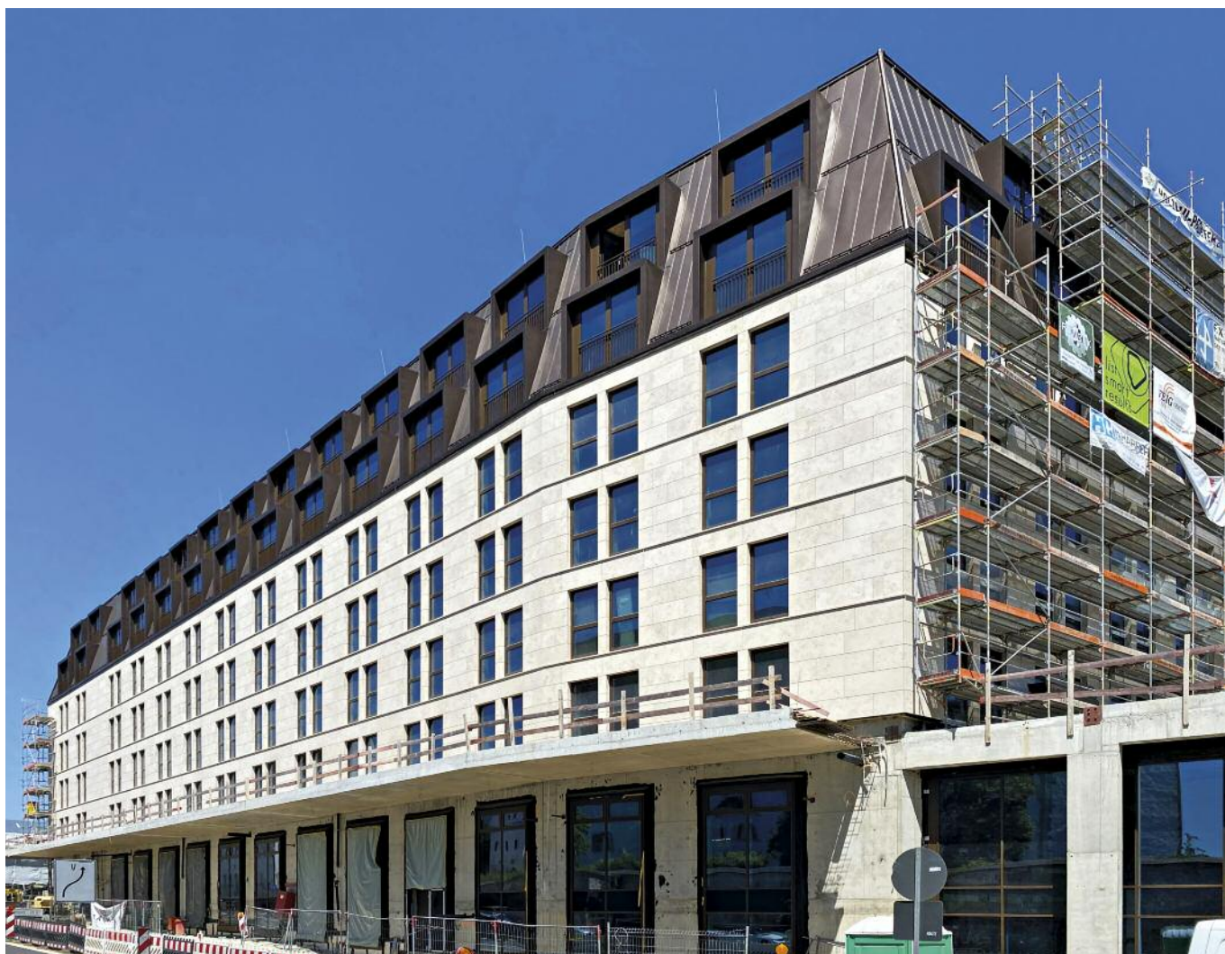
Westansicht des Hotels mit Mansarddach
