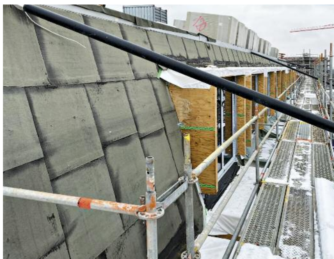
Mansarddach mit verlegter Dampfsperre und montierter Unterkonstruktion der Dachgauben
