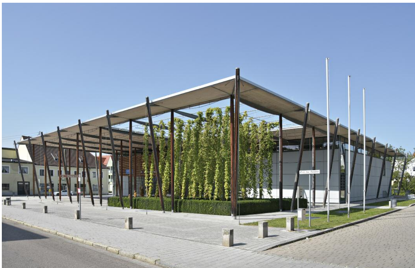
Das Deutsche Hopfenmuseums mit Hopfengarten nach der Sanierung
