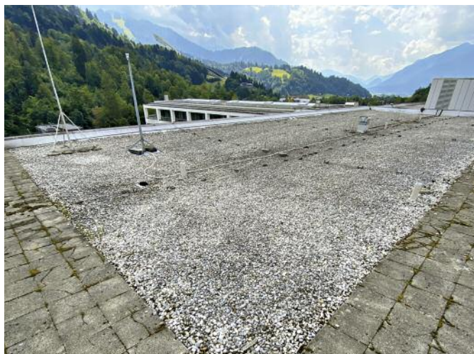
Dachfläche des 1. Bauabschnitts vor der Sanierung
