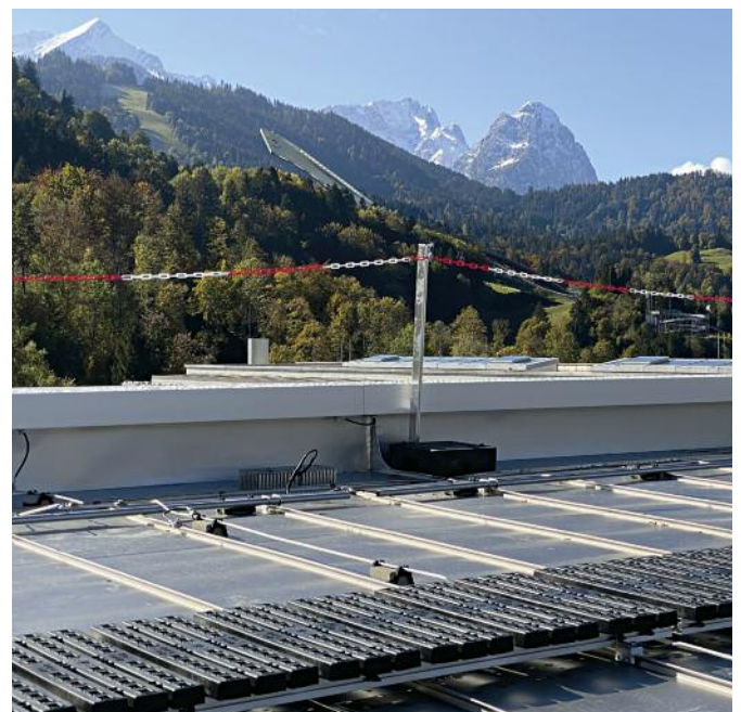
Dachfläche nach Abschluss der Sanierungsarbeiten
