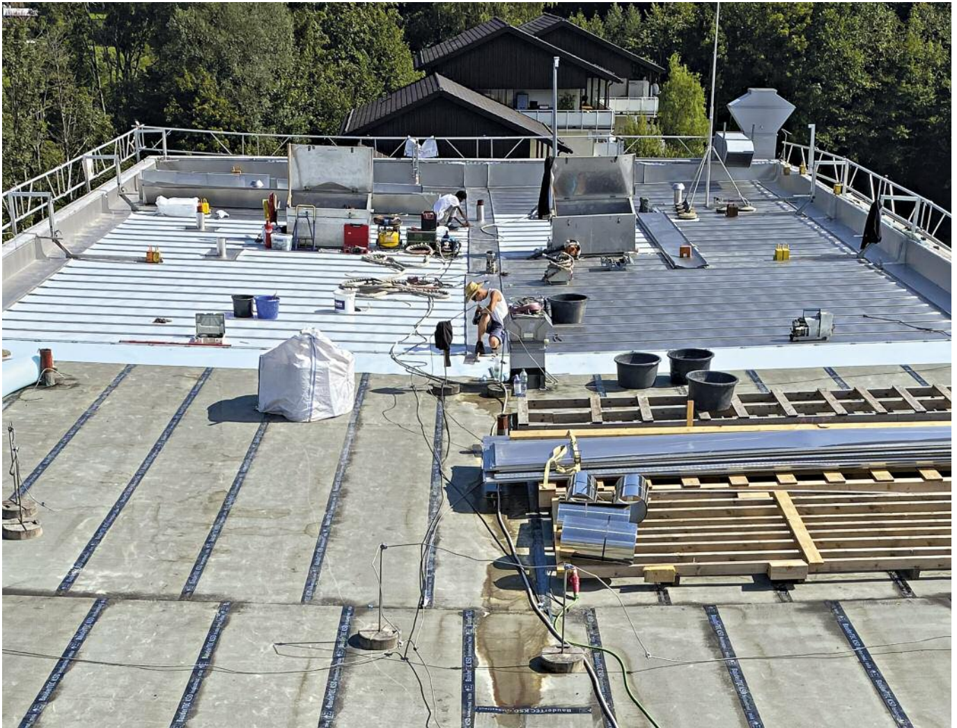
Verlegung der vorprofilierten Metalldachdeckung aus nicht-rostendem Stahl durchgehend rollennaht-geschweißt auf einem Trenn- und Gleitvlies
