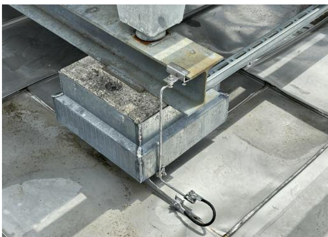
Detailansicht Stütze Rückkühlwerk
