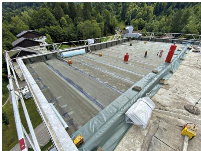
Rückbau der alten Folienabdichtung und Verlegung einer Notabdichtung aus bituminösen Schweißbahnen
