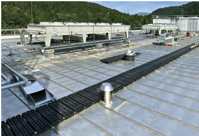
Bauabschnitt mit Rückkühlwerken
