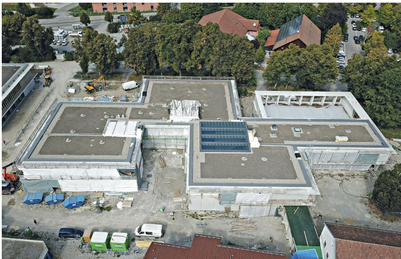
Dachaufsicht der Grundschule Schongau nach Fertigstellung der Dachabdichtung und Dachbegrünung
