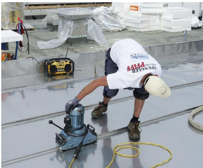
Verlegung der Flachdachabdichtung
