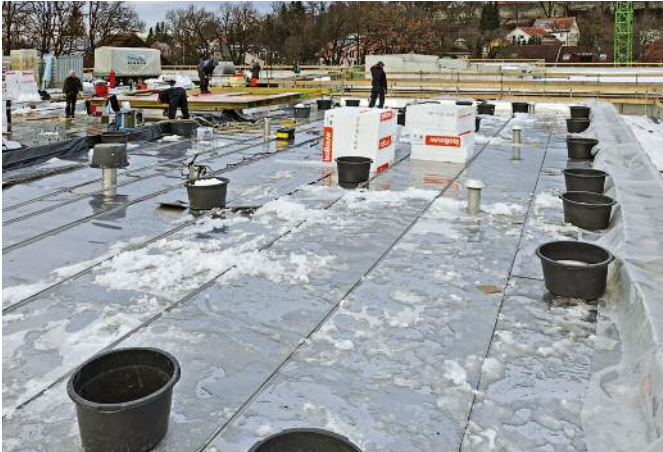
Montagearbeiten bei Eis und Schnee
