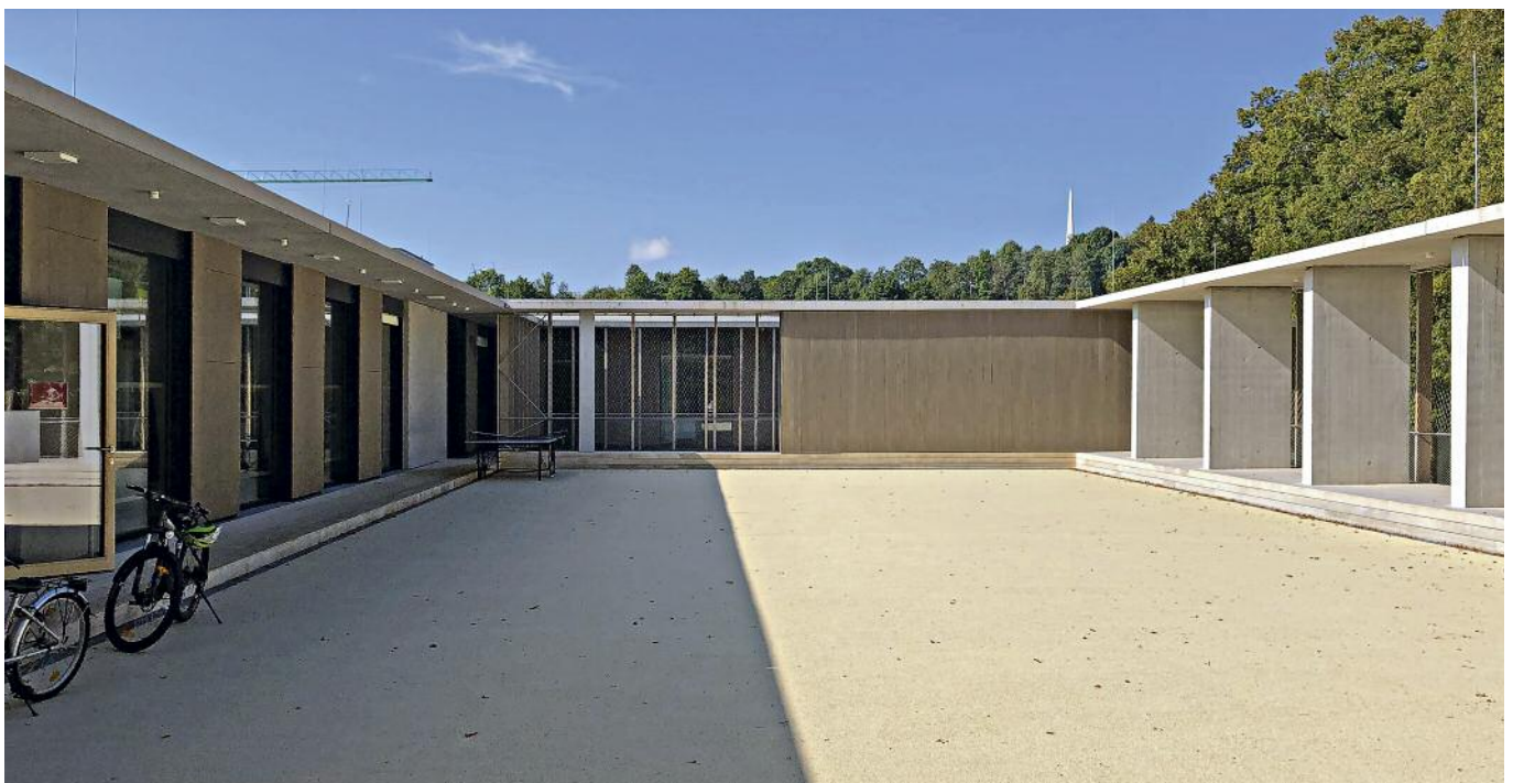
Dach der Turnhalle mit Folienabdichtung und EPDM-Belag
