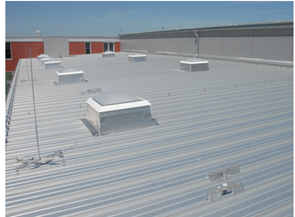
Flachdach nach Sanierung
