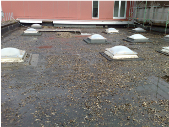
Flachdach vor Sanierung
