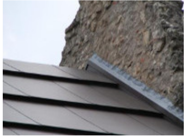
Wandanschluss an Bestand (geschützt mit Flüssigkunststoff)
