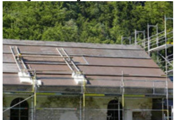
Montage mit Leitergerüst
