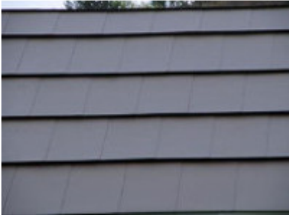
Tafeldeckung mit Liegepfalz und Abtreppung
