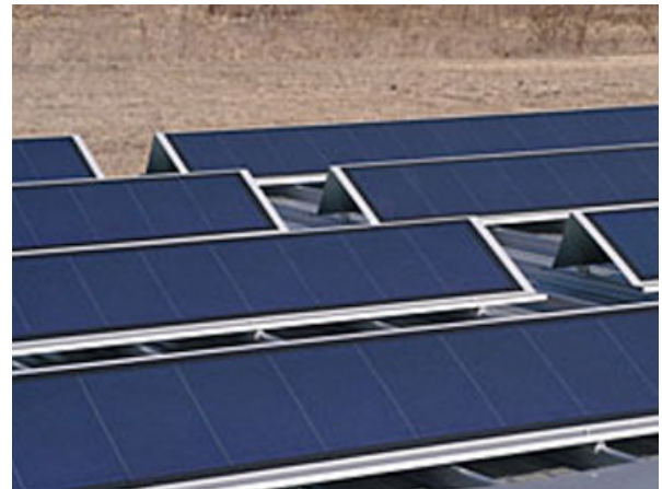
Additive Photovoltaik-Anlage, die Module werden auf das Dach montiert.
